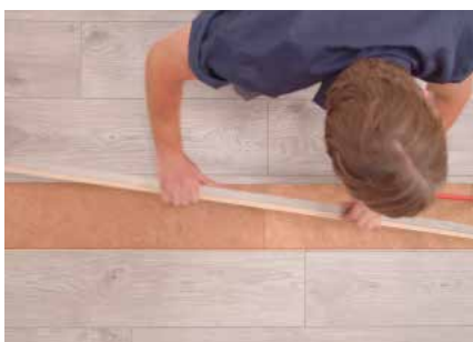
Уход и ремонт
