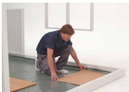
Изоляционная подложка против шума шагов и акустических шумов
