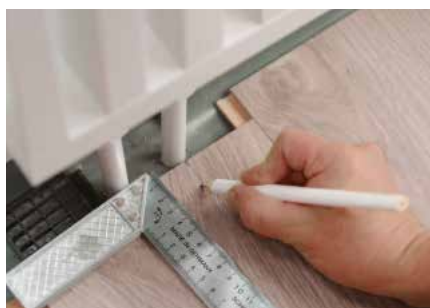
Дверные коробки и трубы отопления
