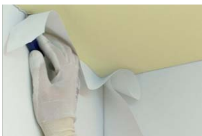
Обрезать покрытие по всей длине при помощи специального резака для обработки швов
