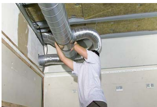
Проверка герметичности вентиляционного канала
