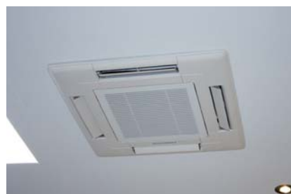
Система кондиционирования: вид после окончания монтажа
