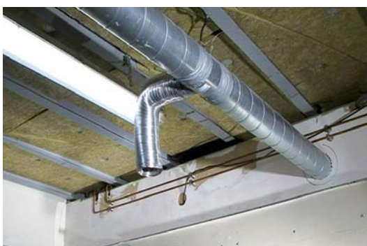
Контроль технических ограничений
