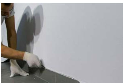
Заделать допуск покрытия
