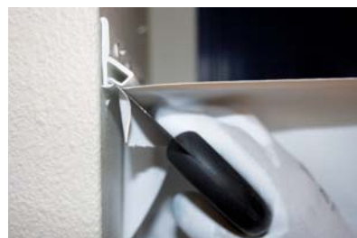
Наклон шпателя под углом 45°
