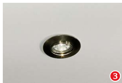
Подключение точечного светильника
