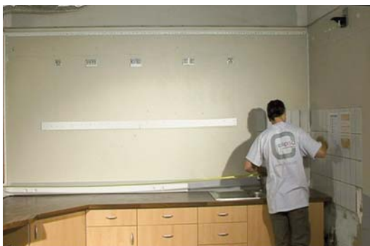
Выполнение замеров при помощи рулетки
