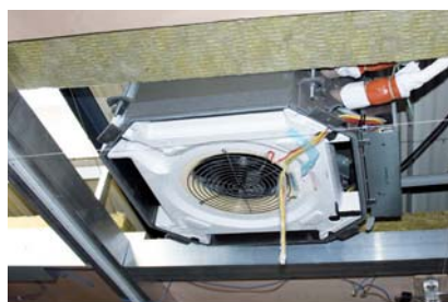
Система кондиционирования: начало монтажа
